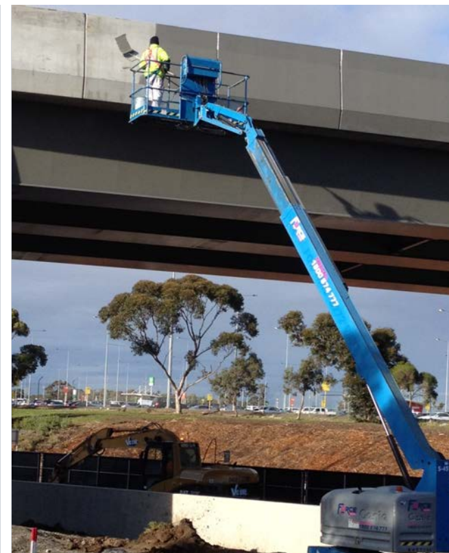
Revêtement de ponts à l'aéroport de Melbourne
