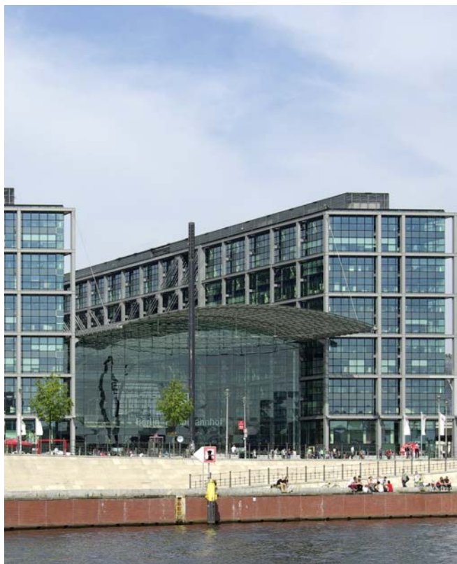
Revêtement de surfaces à la Gare de Berlin
