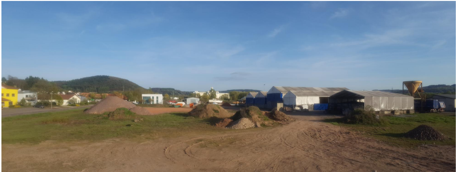
Blick auf Schotter- und Materialablagerungen, Haufwerke, Blickrichtung Osten
