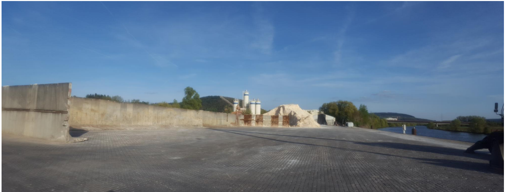
Blick auf Verladebereich, Blickrichtung Westen, rechter Bildrand: die Saar
